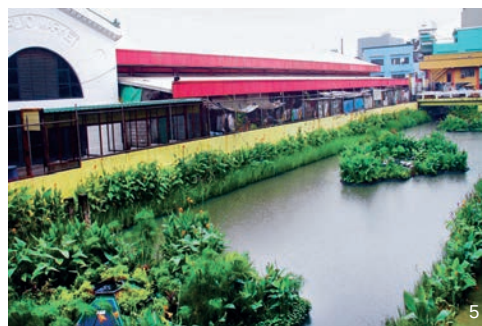
5 修复后的 Paco 市场运河 Paco market canal after restoration
